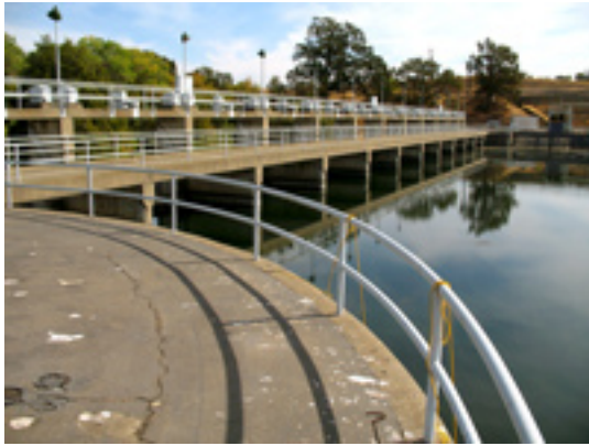
Putah Diversion Dam.
